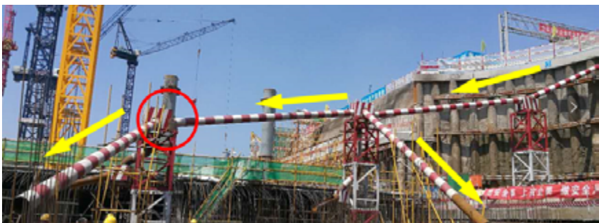
图1. 溜管法浇筑混凝土施工现场。
