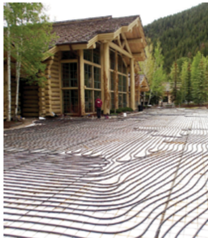
图 6. 爱达荷州太阳谷滑雪场铺设的管道。
