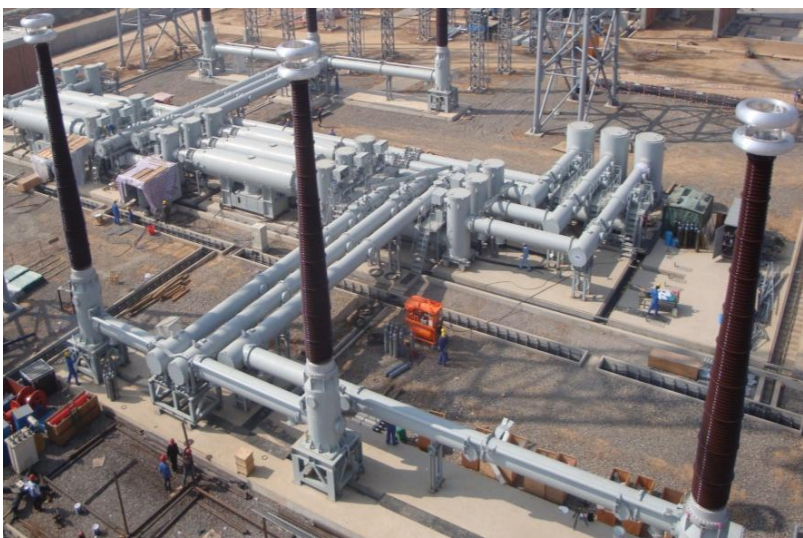
GIS安装现场
